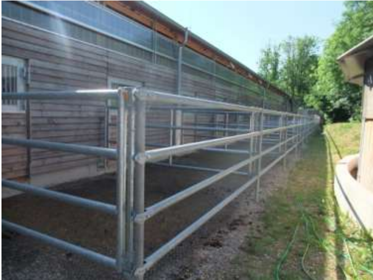
Abbildung: 4-lattige Zinkrohrumzäunung im Pferdezentrum Stadl Paura
